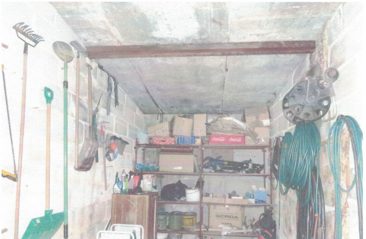
WNĘTRZE POMIESZCZENIA GOSPODARCZEGO
